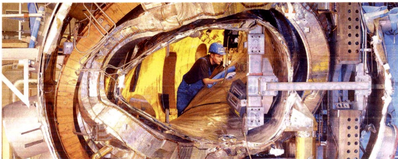
Superconduttori. Un tecnico al lavoro durante la realizzazione della macchina per l'energia a fusione Stellarator Wendelstein 7-X per cui Asg ha costruito bobine non planari e magneti superconduttivi per contenere il plasma
